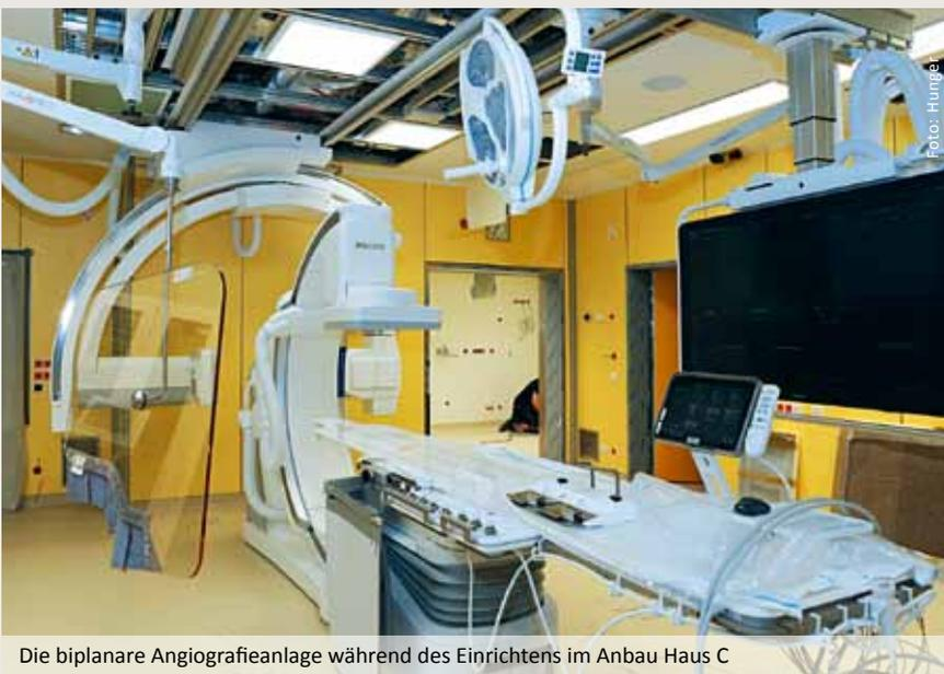
Die biplanare Angiografieanlage während des Einrichtens im Anbau Haus C
